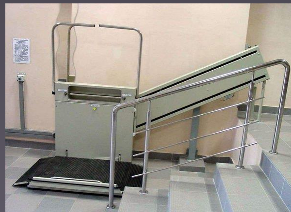
откидные пандусы и подъемные платформы в подъездах
