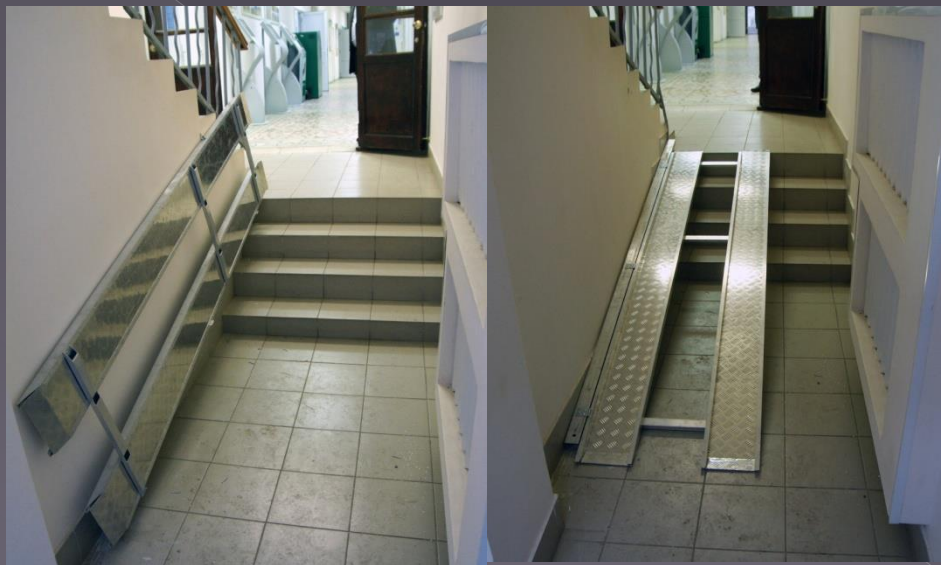
откидные пандусы и подъемные платформы в подъездах
