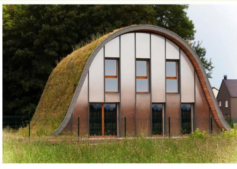
На данных примерах присутствует перепад уровней разных зон: в первом – функциональный, в другой – по всей поверхности выполнена обваловка. Также на втором примере поверхность грунта заводится на стену и крышу зданий. Что делает дом более энергоэффективным.
