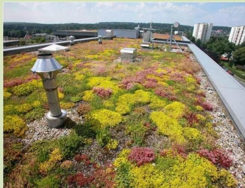
Присутствует разнообразие цветовой палитры, вокруг вентиляционного выхода и по контуру привнесены гравий, впитывающий воду.
